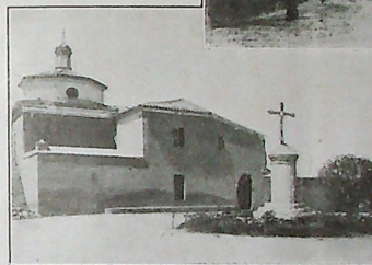
Fachada oriental del Monasterio
