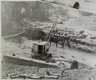
Dois aspectos de los trabajos del nuevo puente sobre el río Guarapiche.
