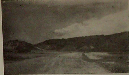
Carretera Cumaná - El Pilar.
