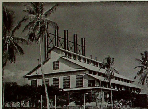
La Planta Eléctrica.
