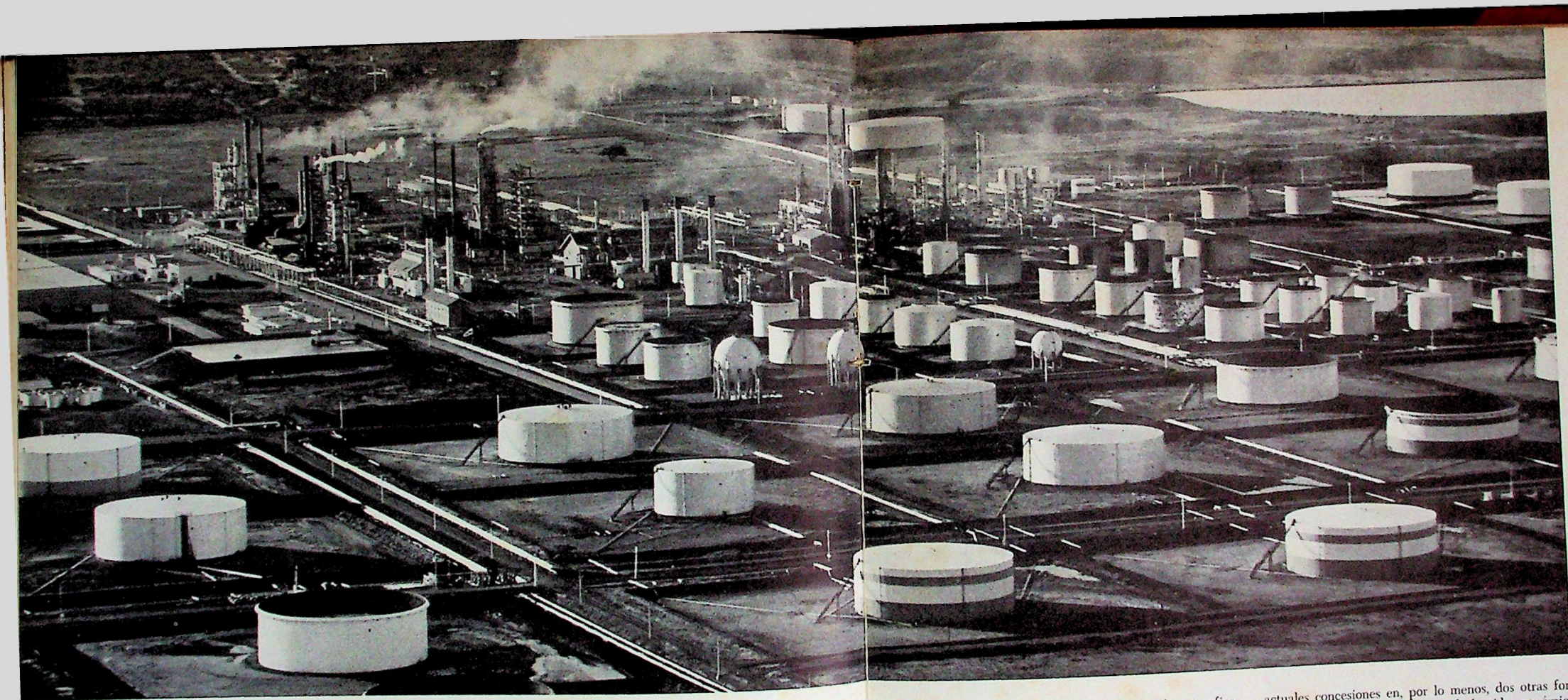
Refinería y tanques de almacenamiento en Ammay
