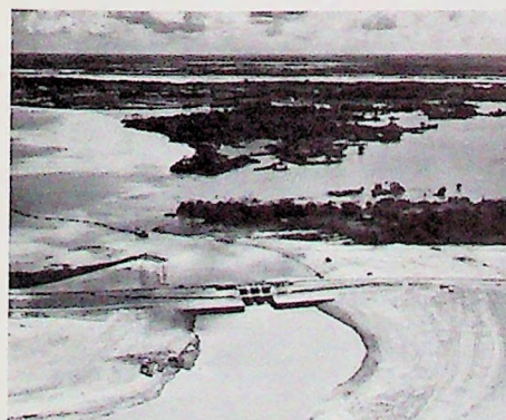
Compuertas de control del cierre del Caño Mánamo, obra básica de infraestructura del desarrollo del Delta del Orinoco. (Cortesía de la C.V.G.)
