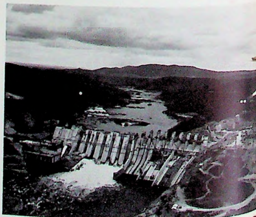
Represa de Guri en etapa de construcción, que será la de mayor capacidad en Venezuela. Su fin es la producción de energía hidroeléctrica y representa solamente una primera etapa del futuro aprovechamiento integral del río Caroní. (Cortesía de la C.V.G.)
