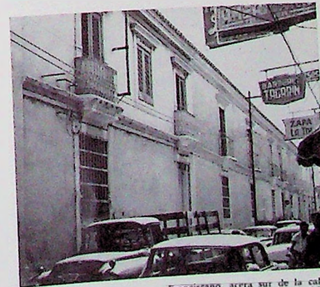
Fachada del antiguo Convento Franciscano, acera sur de la calle 96, antes Ciencias. Este local albergó al Colegio Nacional de Maracaibo y a la Ilustre Universidad del Zulia, entre muchas de las instituciones de mérito que ocuparon el histórico recinto. Razones de ninguna manera poderosas, determinaron su demolición en 1956. En su lugar funciona hoy un estacionamiento para vehículos.
