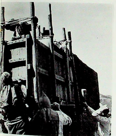
Luego de situados los ocho costales y asegurados, cada uno de los cuatro de un lado, con los opuestos correspondientes, del otro, por medio de fuertes cuerdas de pita amarradas a sus puntas superiores, se procede entonces a la instalación de una de las compuertas, que cierra el extremo del encofrado o tapial.
