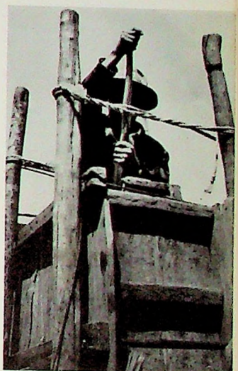
Las cuerdas que unen los costales en pares son, aquí, apretadas por un obrero, quien, para ello, se vale de un tortor o tortol. De este modo las piezas principales de que se compone el encofrado, horma o tapial, quedarán bien afianzadas y en su preciso lugar.
