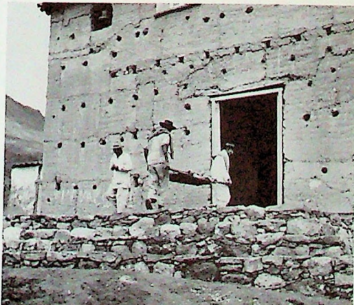
Iniciada la labor de construcción, los zurroneiros trepan escalera arriba, llevando los pesados sacos de tierra preparada. De inmediato los pisoneros continuarán comprimiendo muy bien cada una de las capas de mortero dentro del molde del tapial. Pronto quedará concluida una sólida, duradera y bien terminada pared de tapia.
