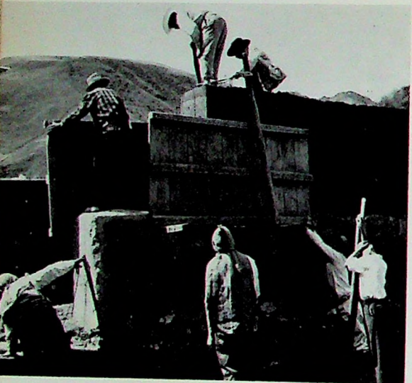
Terminado un cuerpo de tapia cimero, los grandes tableros de los lados, o tapiales propiamente dichos, son desmontados y corridos hacia el extremo libre de la pared interior, a fin de armar allí el encofrado y proseguir la construcción. Ya los operarios embutieron las traviesas o agujas en sus perforaciones correspondientes. Para sostener los tableros, colocan en su sitio el primer par de vigas verticales, a las que se da el nombre de costales o costados.
