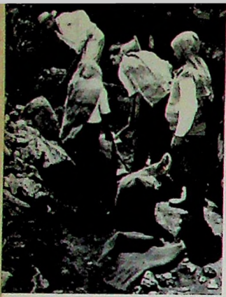
El picador de tierra y los tres zurroneiros, en actividad. El primero separa cuidadosamente los pedruzcos y humedece y amasa bien el mortero que habrá de formar el cuerpo de la tapia. Entre los zurroneiros es fielmente observada la costumbre de cubrirse la cabeza con un saco de lino, a manera de capucha, para evitar que la tierra los ensucie demasiado.
