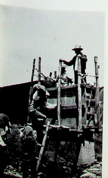
Iniciada la labor de construcción, los zurroneiros trepan escalera arriba, llevando los pesados sacos de tierra preparada. De inmediato los pisoneros continuarán comprimiendo muy bien cada una de las capas de mortero dentro del molde del tapial. Pronto quedará concluida una sólida, duradera y bien terminada pared de tapia.
