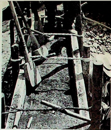
Sobre un bloque de tapia casi terminado, tres pisoneros diferentes. Después que la tierra húmeda queda bien comprimida con la ayuda de los más aguzados, entonces, para aplanar la superficie, son aplicados los de grueso mayor.
