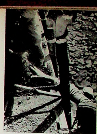
Colocación de la última capa de tierra apisonada sobre un bloque de tapia, o adobón. A unos veinte centímetros debajo de la superficie superior, han sido enterrados, en posición transversal, cuatro prismas o cuartones gruesos de madera, tan largos como el espesor de la pared, los que dejarán abiertos en ella los orificios necesarios para, a su tiempo, recibir los agujeteros que habrán de ser insertados.
