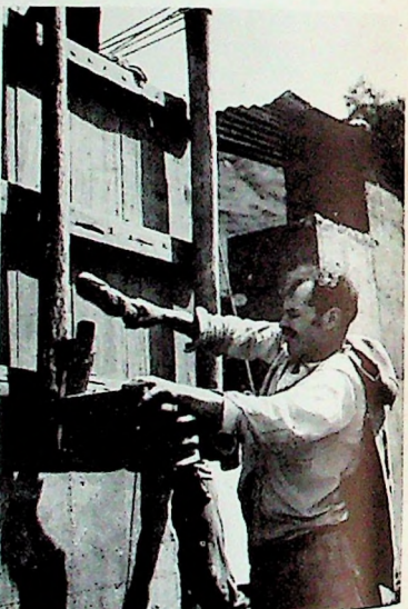
Los agujeteros tienen practicadas escopleaduras cerca de sus extremos, y, en esas aberturas, van introducidas las espigas en que terminan, por abajo, los costados o vigas verticales. Uno de los zurroneiros ajusta en su lugar, con cuñas, la espiga de uno de estos costales.
