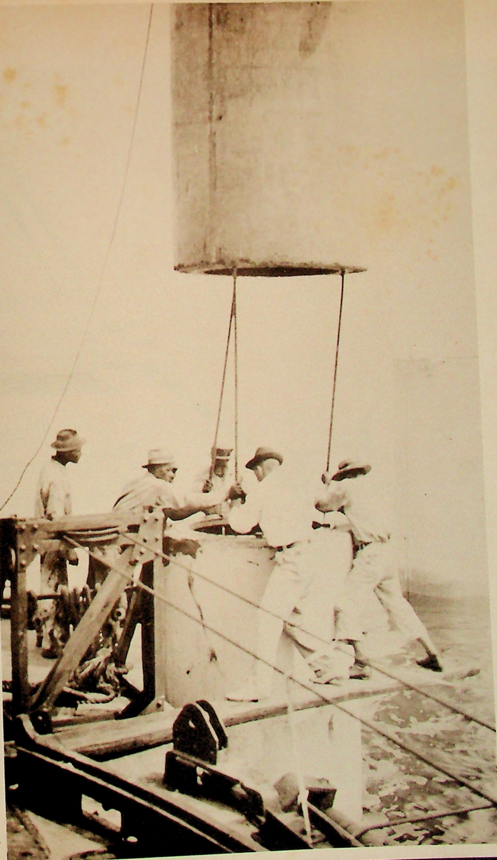
Los primeros pilotos, de madera, fueron sustituidos por los de concreto, huecos, llamados «caissons».
