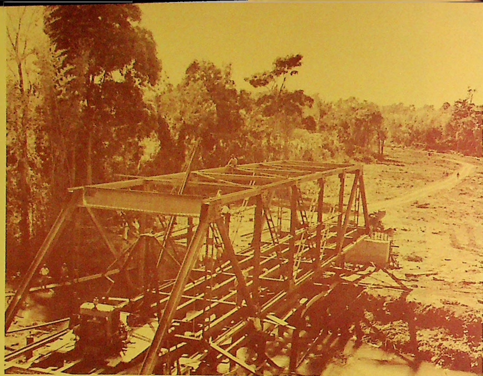
Construcción del primer puente sobre el río Guarapiche, en Jusepín. (1940).
