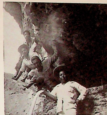
Valerio frente al primer tanque de almacenamiento.
