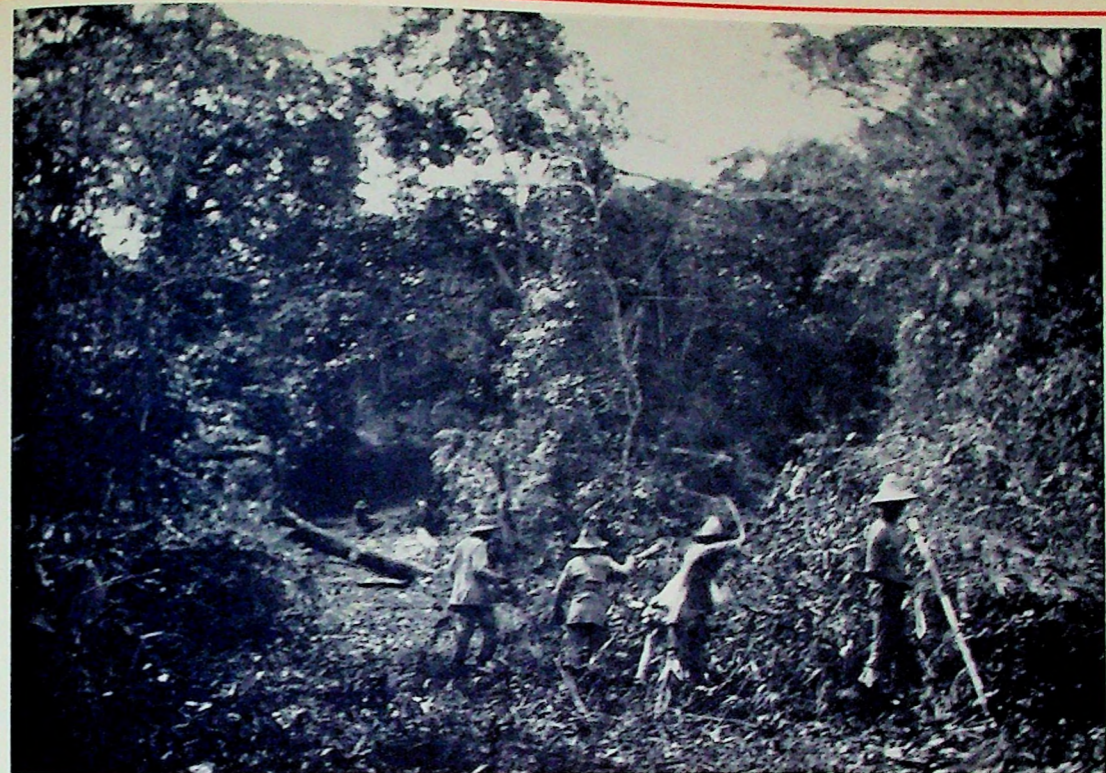
A fuerza de abrir picas la carretera llegó a Perro Seco.
