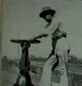
Un medidor en el momento de abrir la llave para el paso del petróleo.
