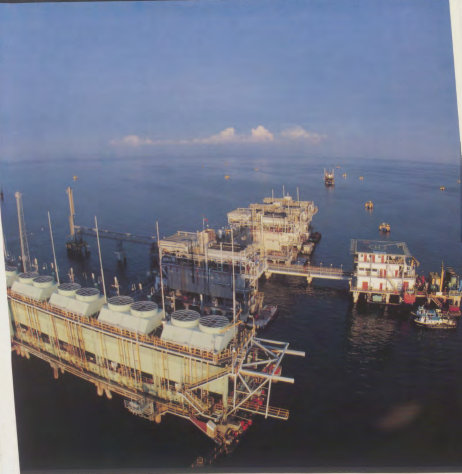
El proyecto Infraestructura y Automatización de la red de Gas de Occidente (Infragas), aumentará significativamente la capacidad de manejo de gas de Maraven.
