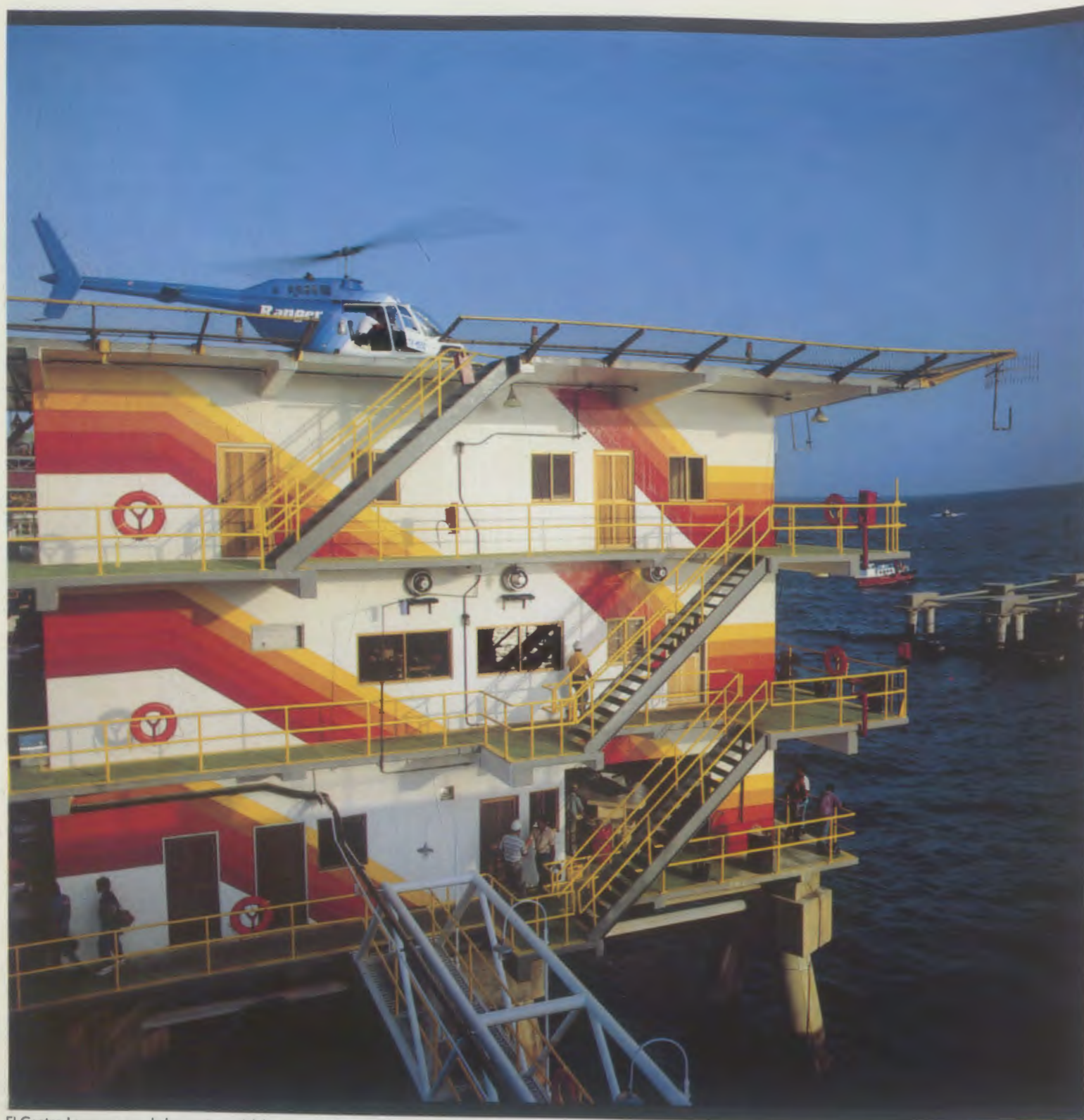
El Centro Lama es uno de los cuatro módulos construidos para mejorar la calidad de vida del personal que trabaja en el Lago de Maracaibo.
