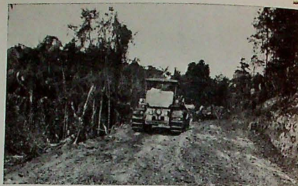
Tractor haciendo corte para carretera.
