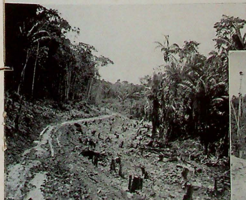
Tala a lo largo de la vía de la carretera y el corte de guía.
