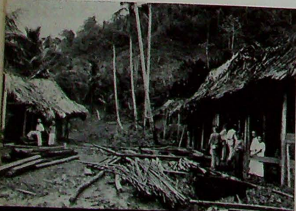
Los Morros de San Juan donde se construirán los edificios de la Aduana y el Puerto y donde terminará la carretera.
