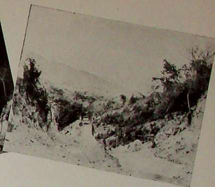
Tractor haciendo corte en el Cerro Iglesia para carretera.
