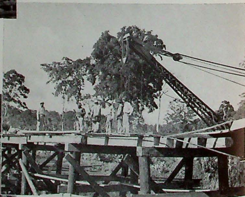
Colocando andamiaje para la erección de la armazón de acero.
