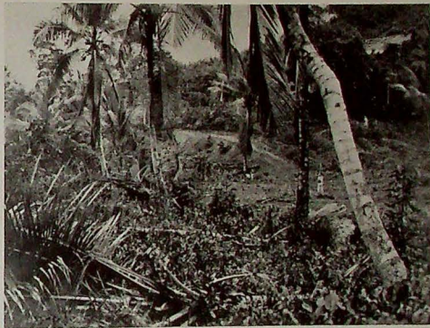
Carretera Caripito-Los Morros de San Juan.—Ingenieros colocando estacas de elevación
