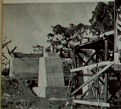
Estribos completados en la orilla norte del Rio Caripe.
