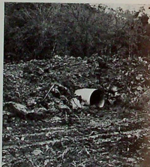
Alcantarilla colocada y parcialmente cubierta.
