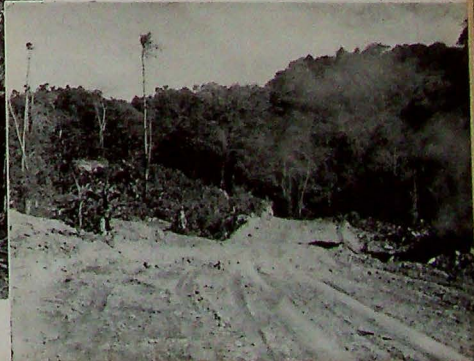
Superficie de la misma carretera parcialmente completada.
