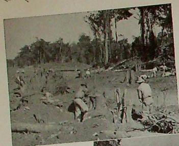
Cuadrilla limpiando el terreno.
