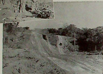
La carretera en construcción.
