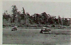
Tractores arreglando el terreno para el parque.
