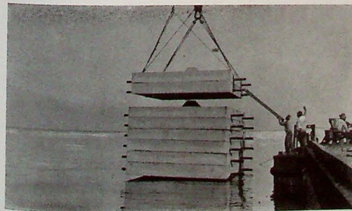
Enormes bloques se descargan sobre los pilotes, para hacer que estos penetren.
