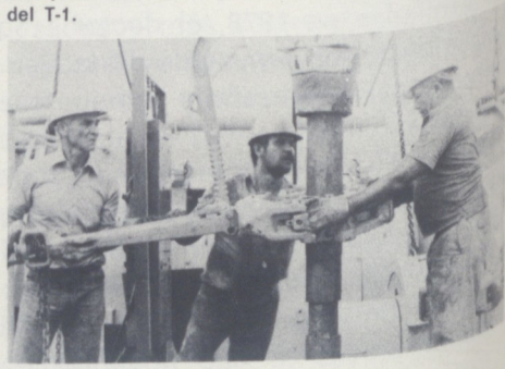
Obremos colocando la primera mecha de perforación.
