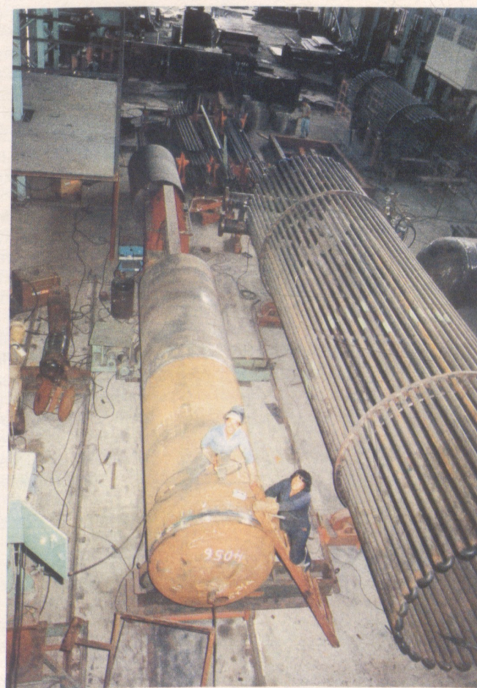
Operarios venezolanos en la construcción de un generador de vapor. A un lado los serpentines de alta presión.
