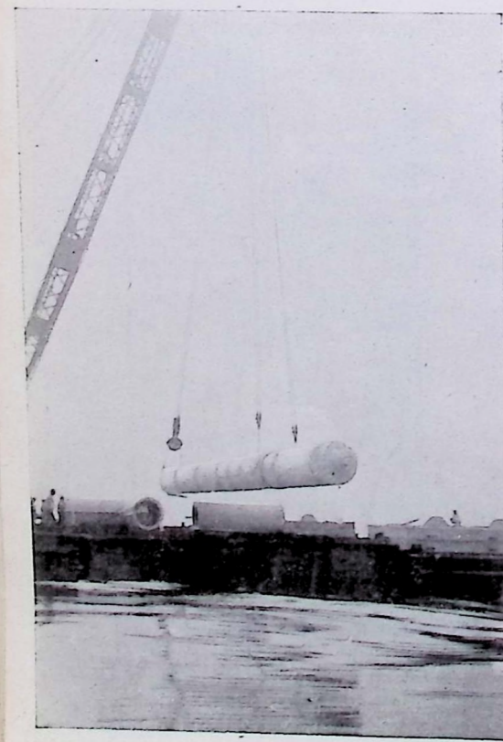
Un "pilote" hueco cuyo peso es mayor de 50 toneladas levantado por una de las grúas para entregarlo al "martinete".
