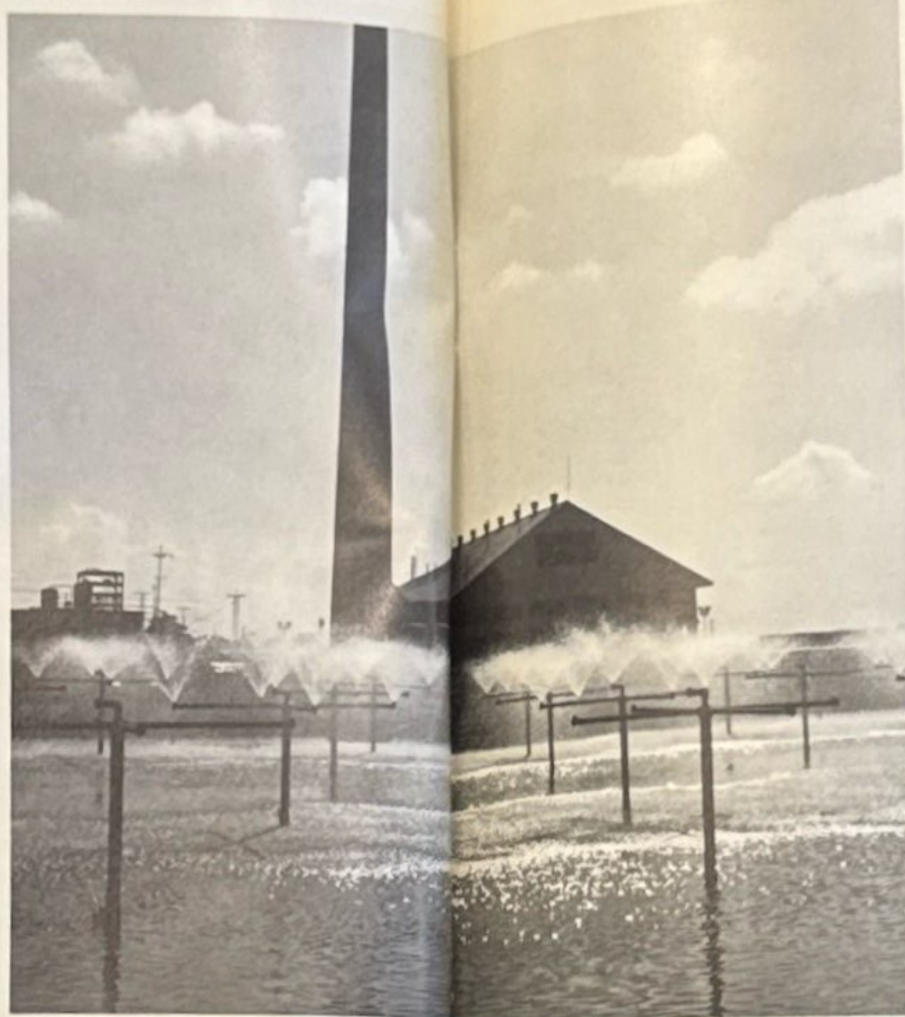
La Planta Eléctrica de Caripito continúa en funcionamiento después de cincuenta años de construcción.
