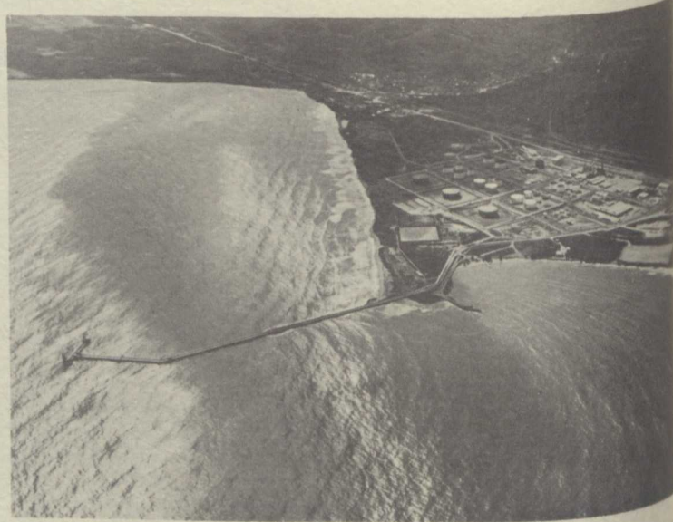
Vista aérea de la Refinería.
