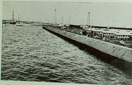
Parte de la muralla de ocho kilómetros de largo que protege a Lagunillas.
