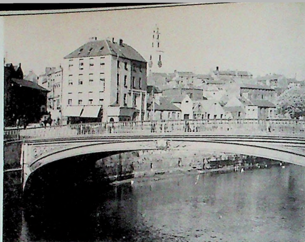
El puente de North Gate, en Cork. En segundo plano la iglesia de St. Mary's Shandon
