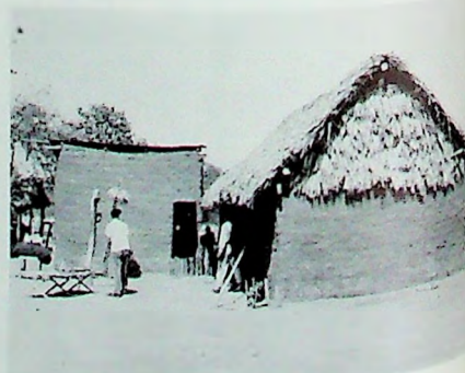
Primitivas construcciones de bahareque y palma son las viviendas del hato
