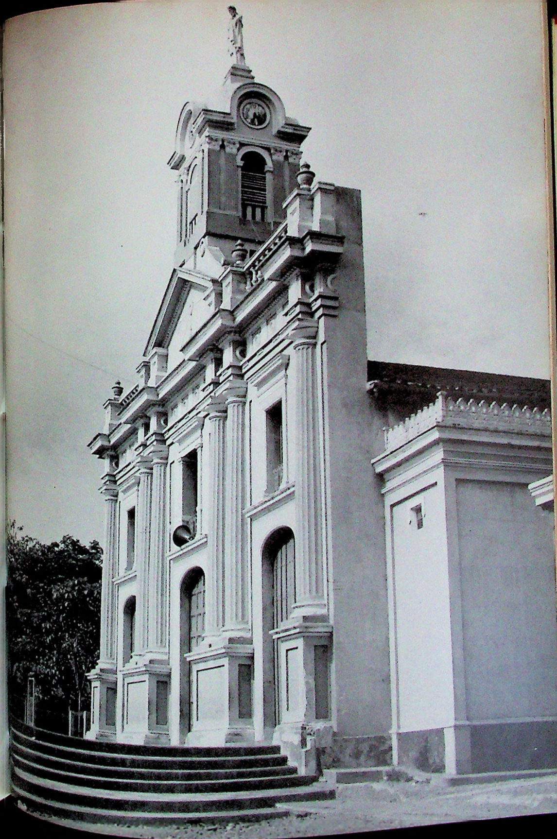
Iglesia de Claret En la torre se levanta una estatua de Santa Rosa de Lima
