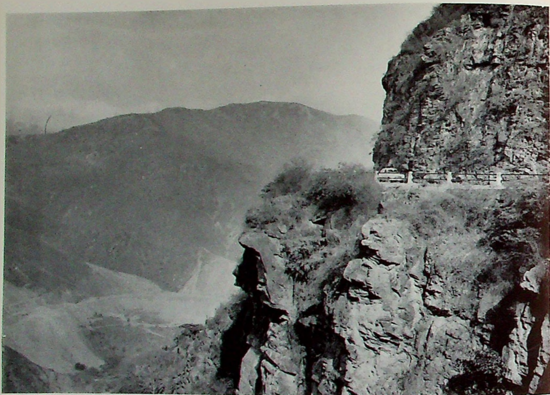
Detalles del camino hacia El Litoral. En primer término se ve la actual carretera de La Guaira y al fondo, a la izquierda, un aspecto de la gran vía en construcción.
