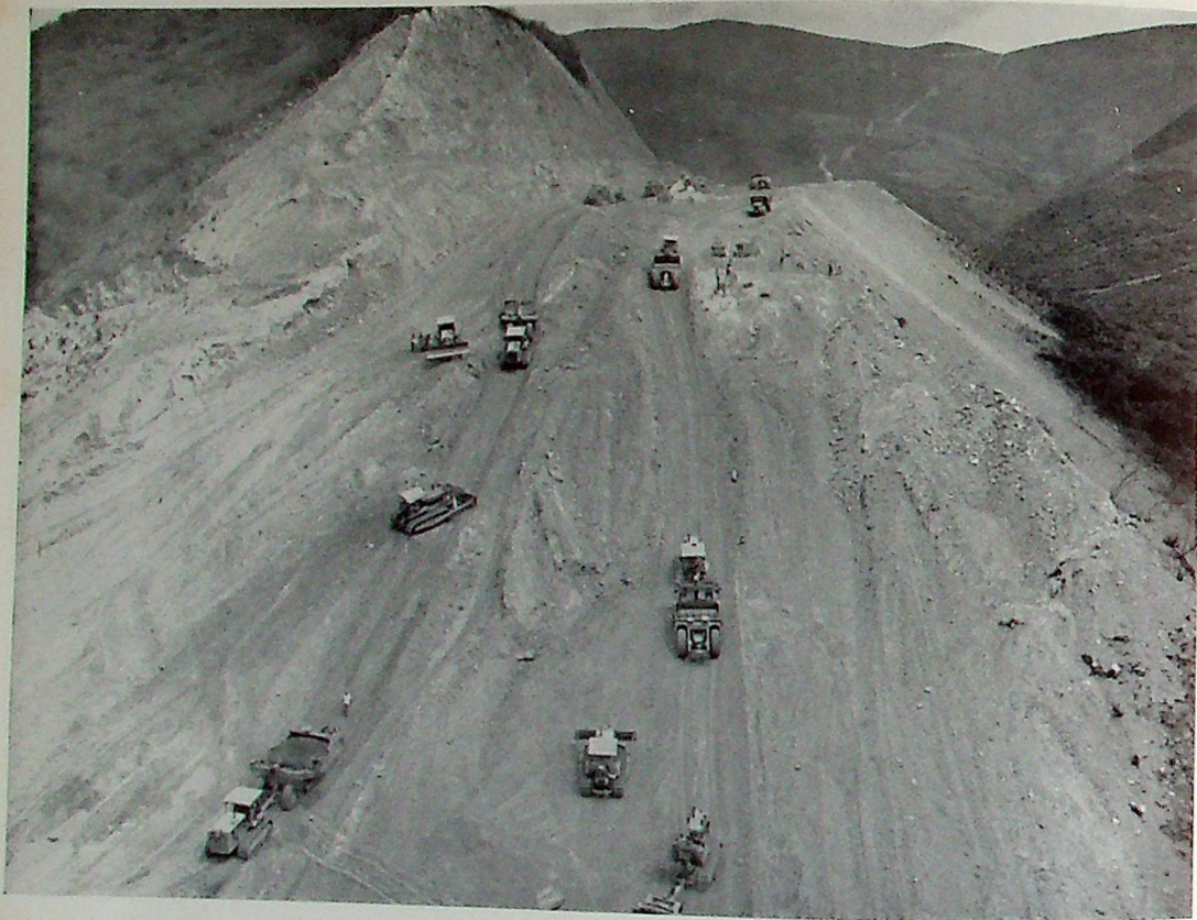
Movimiento de tierras para la explanación de la vía.
