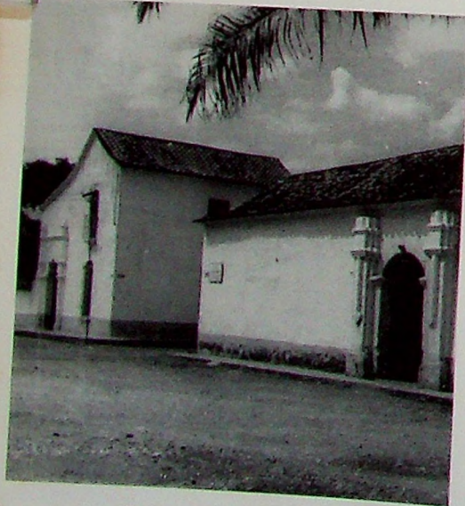
El muro. Casas de Arauca.
