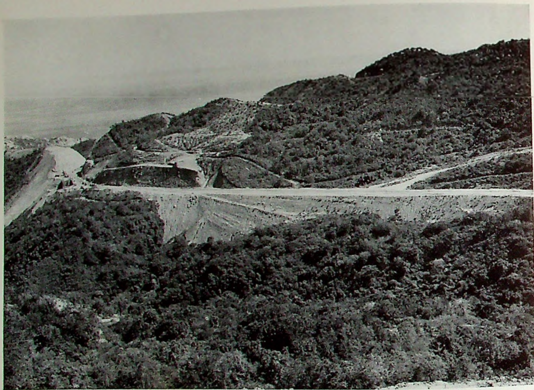
Cortes y rellenos para explanación de la pista.
