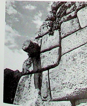
En estas protuberancias cilíndricas de piedra se amarraban los techos
