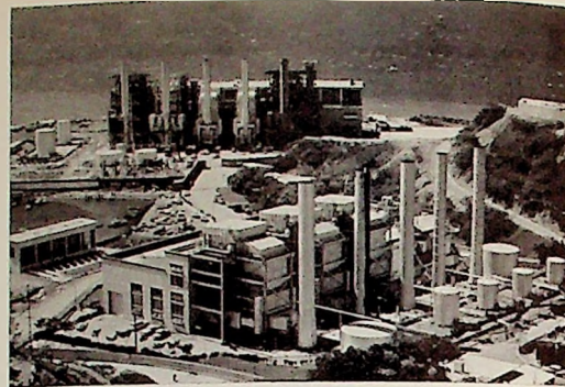
Planta Eléctrica de Arrecifes
