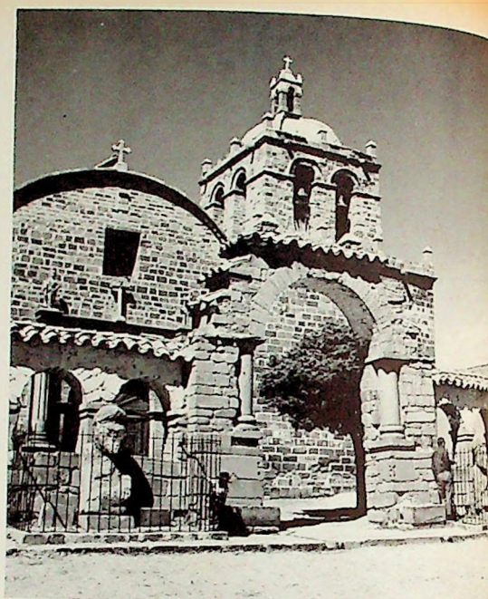
El templo católico de Tiwanaku, construido por los españoles con las piedras sacadas de las vecinas ruinas
